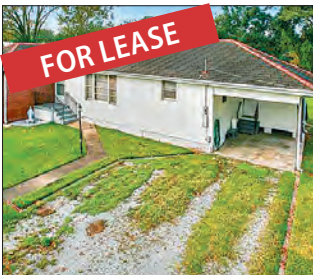
343 Park Avenue • Destrehan
